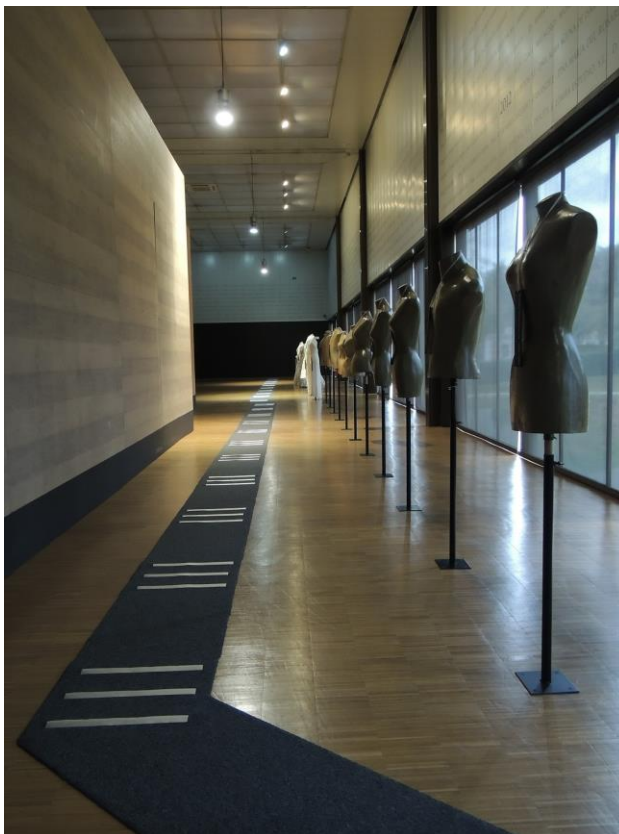
Foto 18. Piso con Señalización Táctil 52
